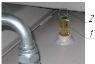
Рисунок 7 – Клапан предохранительный пружинного типа
